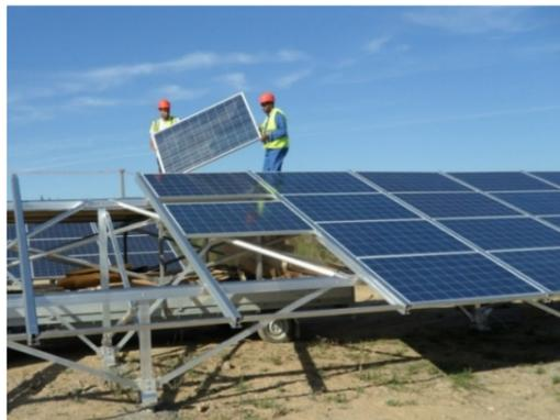
■ Photographie 4 : Exemple de mise en place des panneaux sur les structures<sup>4</sup>
