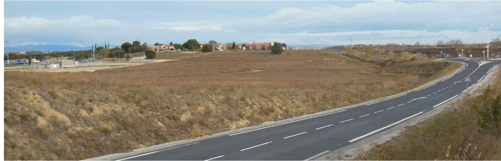
Photo 7 : Vue en direction du le rondpoint et du « Village Catalan », depuis la RD 40 – ETAT ACTUEL
