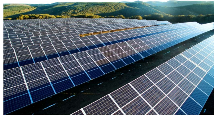
Exemple de structure fixe (photo RES)
