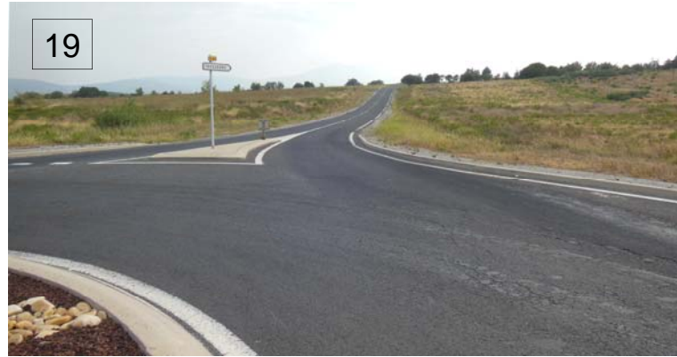
19 La RD 40, vers Tresserre en traversée du secteur Sud de l'aire d'étude
