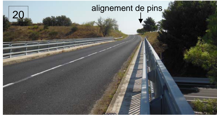
20 La RD 40 en provenance de Tresserre Franchissement de l'A 9 Alignement de pins en sommet de côte
