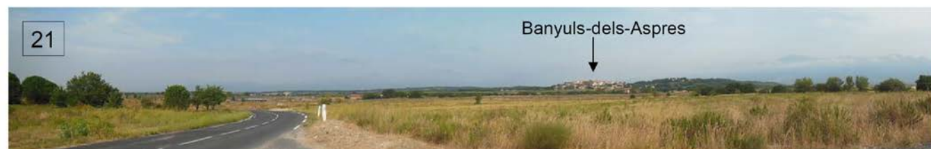
La RD 40, vers l'Est, en traversée du secteur Sud de l'aire d'étude
