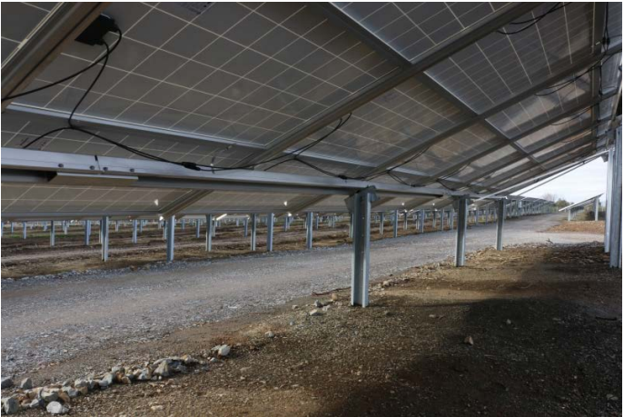
Photographie 3 : Exemple de pistes empierrées 3
