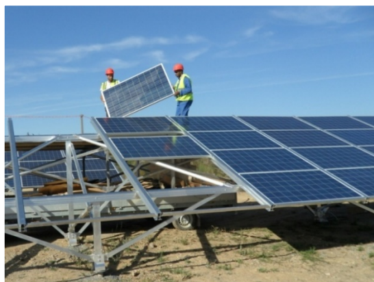
■ Photographie 4 : Exemple de mise en place des panneaux sur les structures 4
