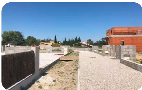
Noues et sols perméables dans l'éco-quartier de Tresserre
