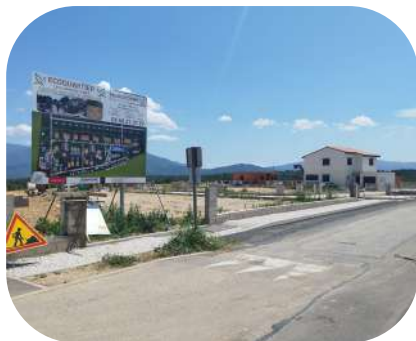
Éco-quartier en cours de réalisation à Tresserre
