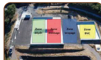
Aire de broyage des déchets verts
